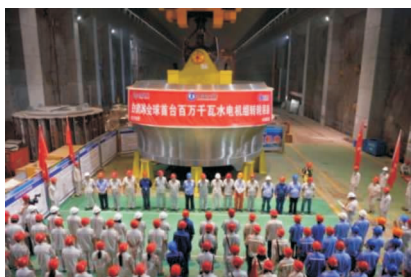
图9 1 000 MW 白鹤滩水轮机转轮吊装
