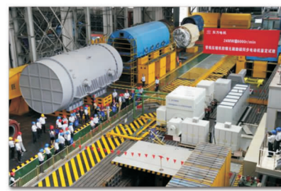
图17 24 MW 管线压缩机驱动同步电动机厂内试验
