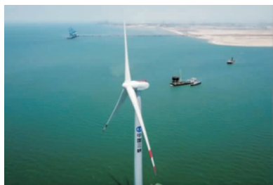
图13 10 MW 海上风电在福建兴化湾风场并网发电
