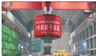
图12 长龙山抽水蓄能机组发电机转子吊装
